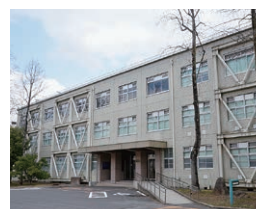
■総合理工学部2号館
