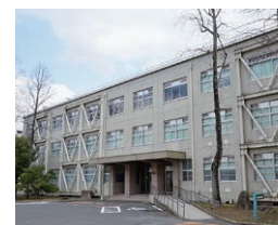
■総合理工学部2号館
